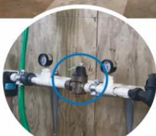
تنظیم کننده فشار ۲۵ میلی متری
