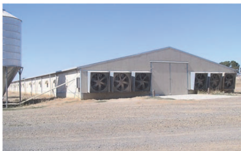
شکل ۲-۱۳- نمای خارجی سیستم تهویه سالن مرغداری (هواکش‌های سیستم تونلی)
